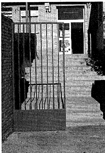
El acceso principal, con escaleras.
