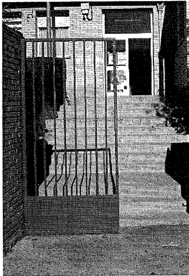
El acceso principal, con escaleras.
